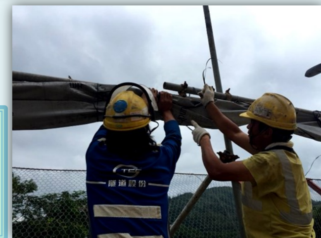
(左圖)緊急應變工程團隊於大雨後即時清理淤泥 (右圖)工人在惡劣天氣前穩固易吹倒的工地物件 (下圖)工人將圍欄繫穩
