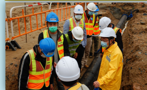
(左圖)工程團隊與水務署代表實地視察光纖的鋪設及安裝過程
