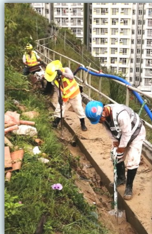
(左圖)緊急應變工程團隊於大雨後即時清理淤泥 (右圖)工人在惡劣天氣前穩固易吹倒的工地物件 (下圖)工人將圍欄繫穩
